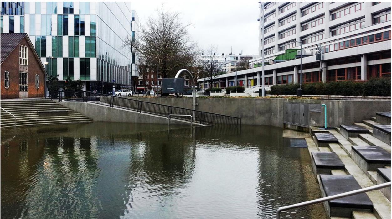
**FIGURA 49** Exemplo de reservatório multiuso fechado (Watersquare Bentheplein, em Roterdã, nos Países Baixos)
