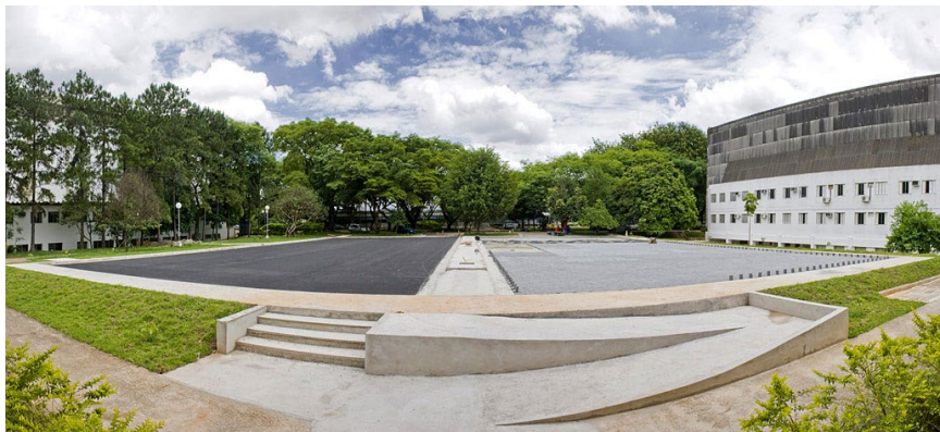
Figura 23 Pavimento permeável no CTH-USP.
