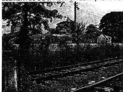
MURO JUNTO A FERROVIA
